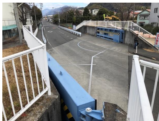
写真6 水道町の陸閘(りっこう)
