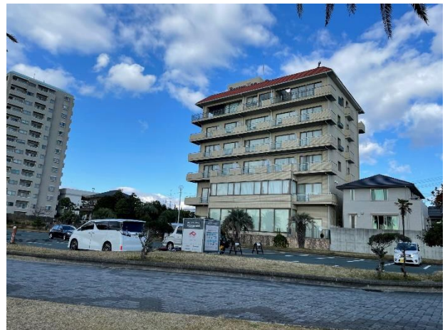
小松屋旅館跡地。現丸八真綿の研修所・保養所 Bentenkan
