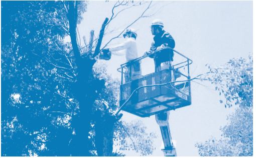
高い所での作業や校舎のメンテナンスもしています
